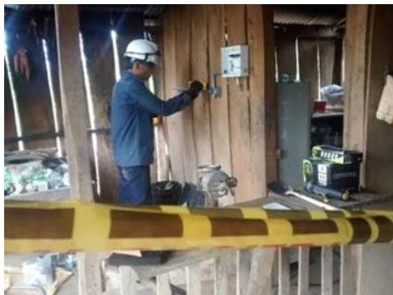
Figura 9. Instalación de redes eléctricas internas
