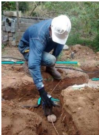
Figura 5. Excavación e instalación de sistema de puesta a tierra
