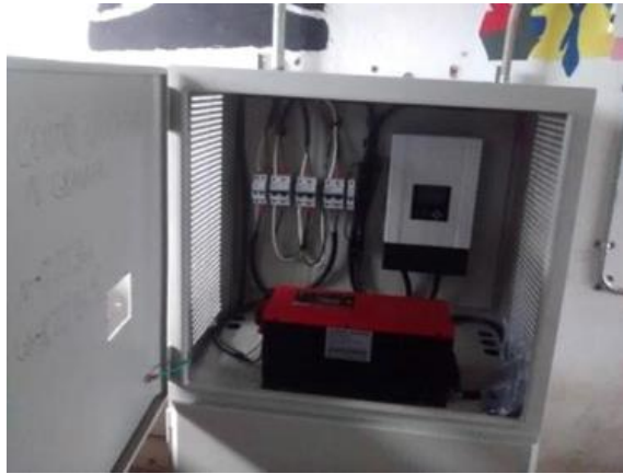
Figura 8. Montaje típico de inversor y controlador dentro de gabinete
