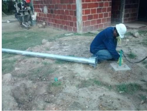
Figura 3. Ubicación soporte de paneles
